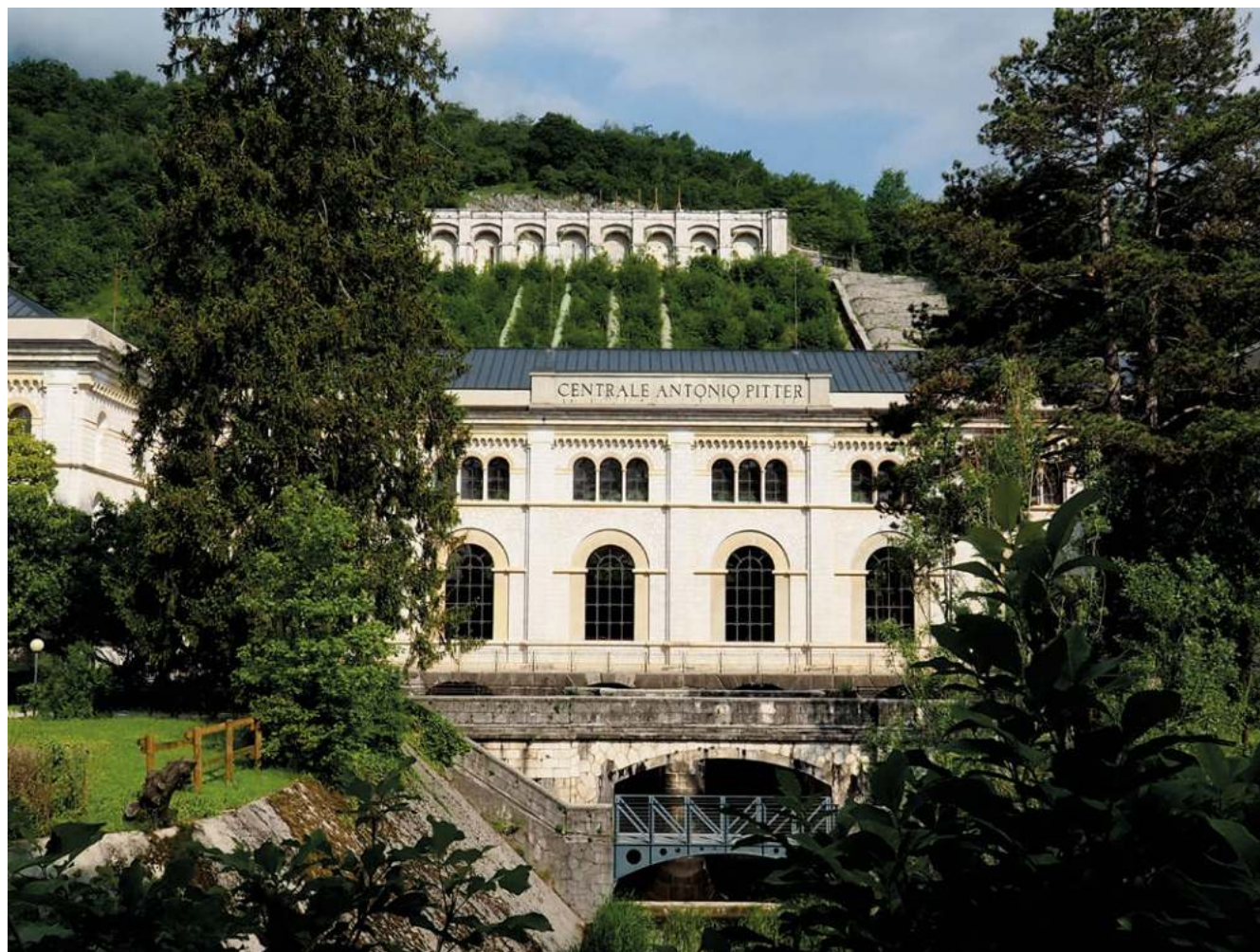
CLAUDIA ALBERTI Centrale idroelettrica
