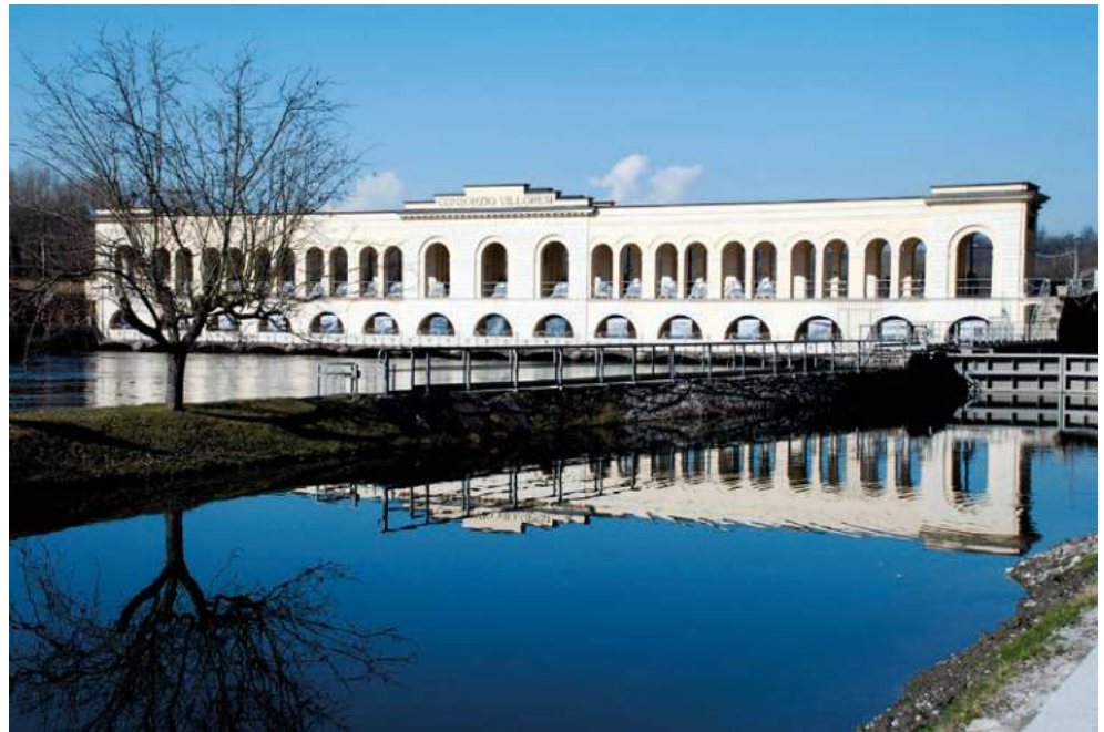
AUGUSTO BARBIERI Diga del Panperduto e Canale Villoresi
